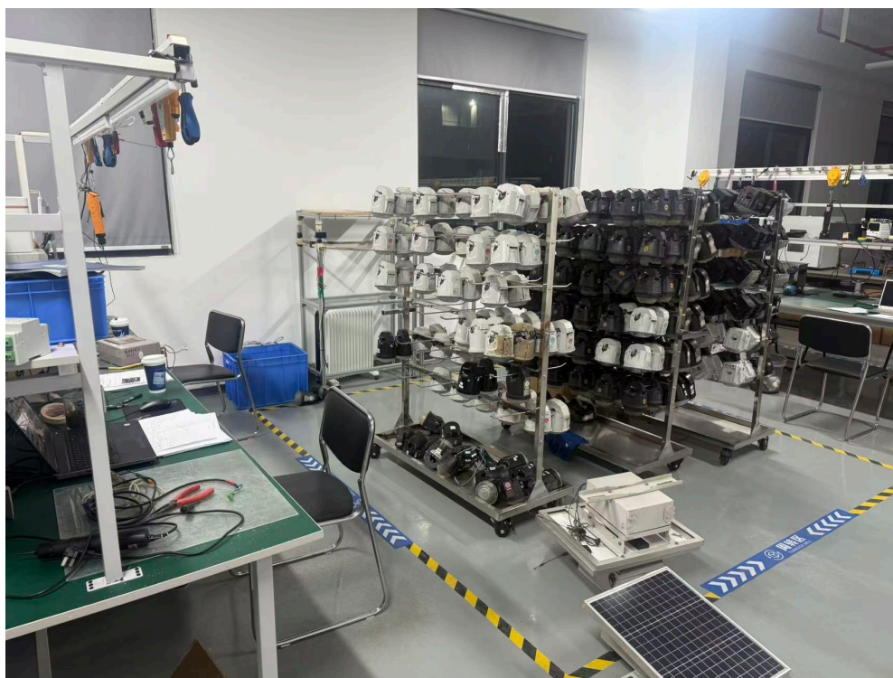
图 1 电力设备运维现场
